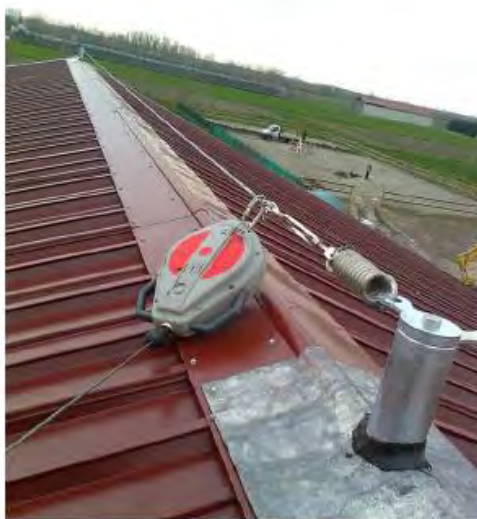
– esempio di linea vita da installare
